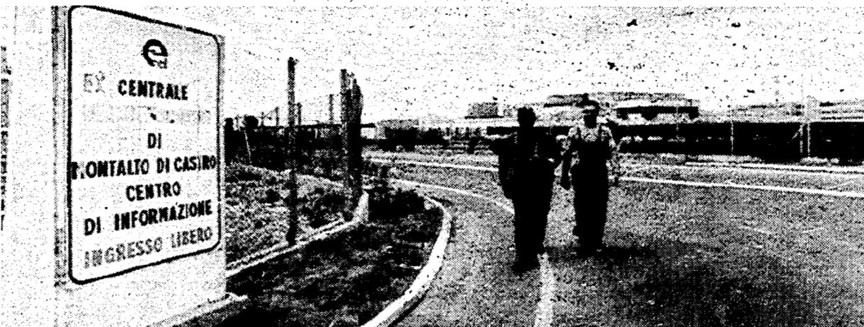
Una immagine dell'ex centrale nucleare di Montalto di Castro. Sotto un gruppo di operai quando ancora nel cantiere si lavorava
