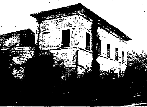
La casina delle Rose com'è oggi dopo trent'anni di abbandono
