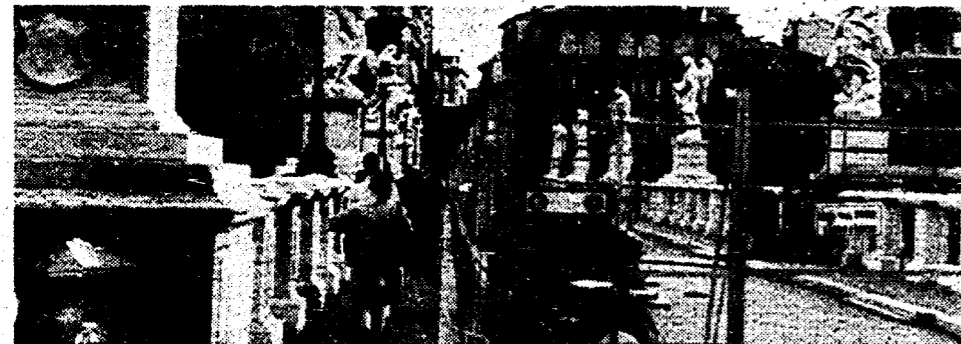
A fianco e sotto Ponte Sant'Angelo chiuso al passaggio. I lavori dureranno quasi un anno
