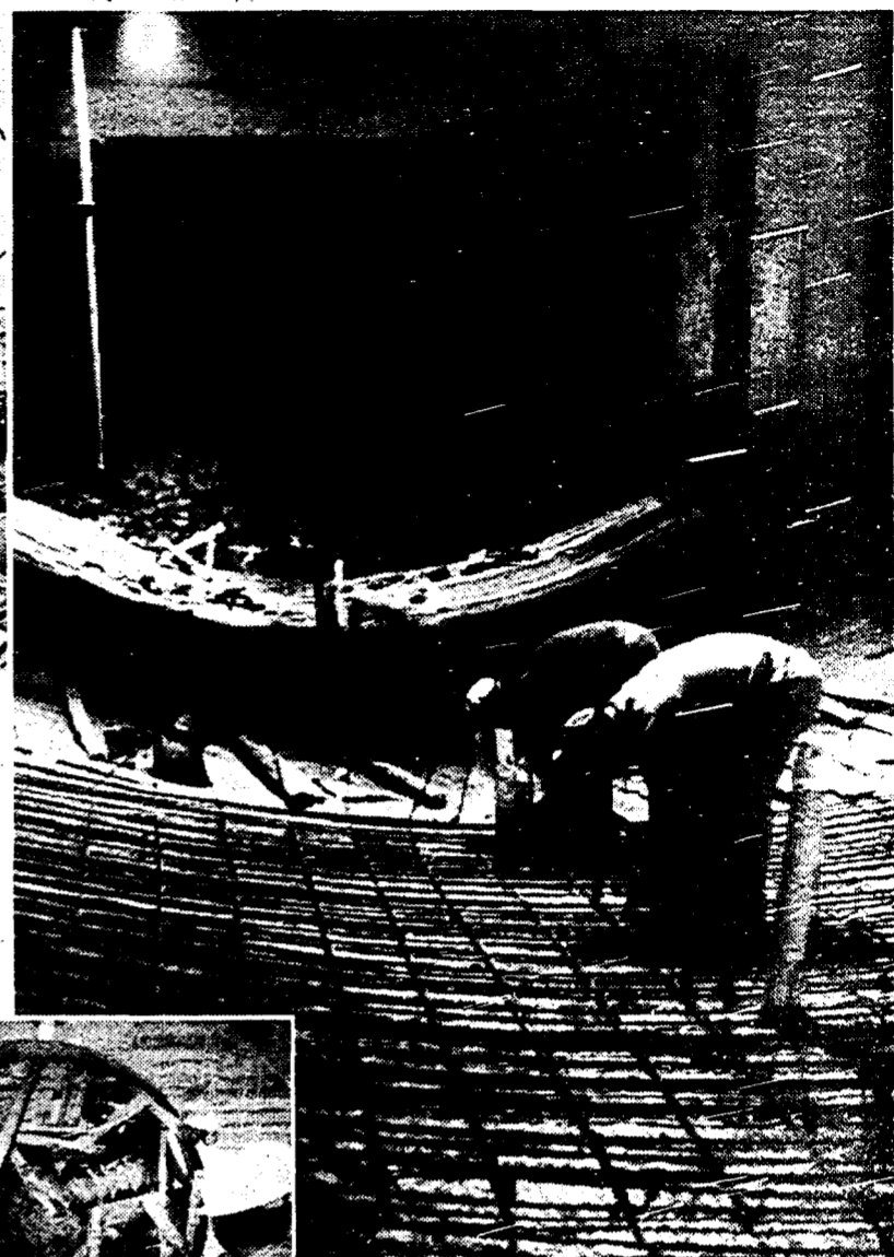
Un cantiere vicino al Colosseo, operai al lavoro nei sotterranei della metropolitana
