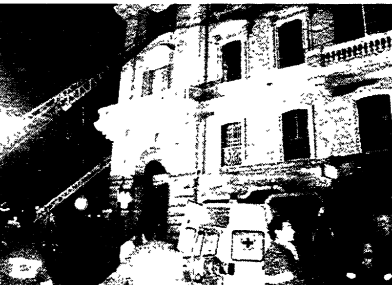
Il palazzo di piazza Vittorio dove ieri è crollato un solaio
