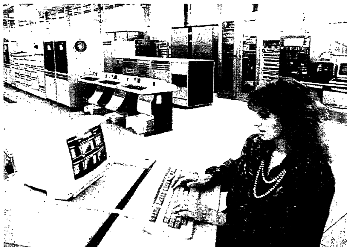
Impianti dell'Italtel per la gestione computerizzata delle linee telefoniche
