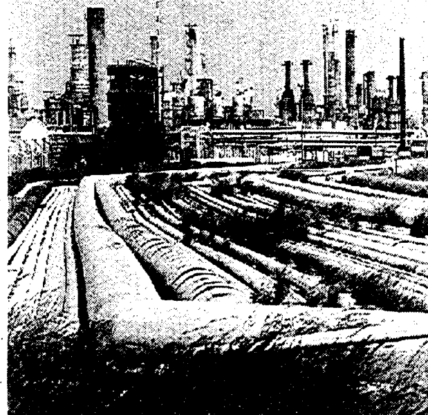
Impianti chimici a Porto Marghera
