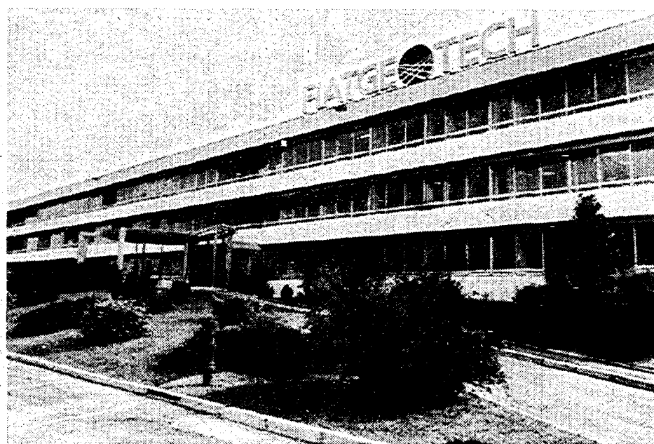
La sede di Modena della Fiat-Geotech/New Holland
