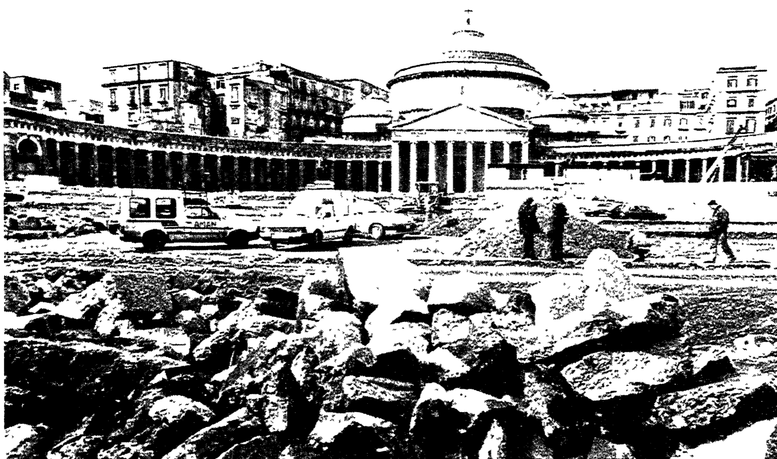
Lavori a piazza del Plebiscito a Napoli per il G7
