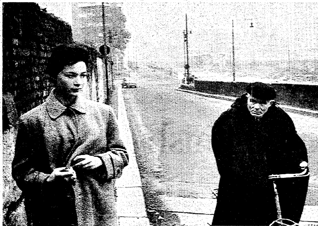
1961. Sul vecchio cavalcavia dell'Isola Garibaldi
