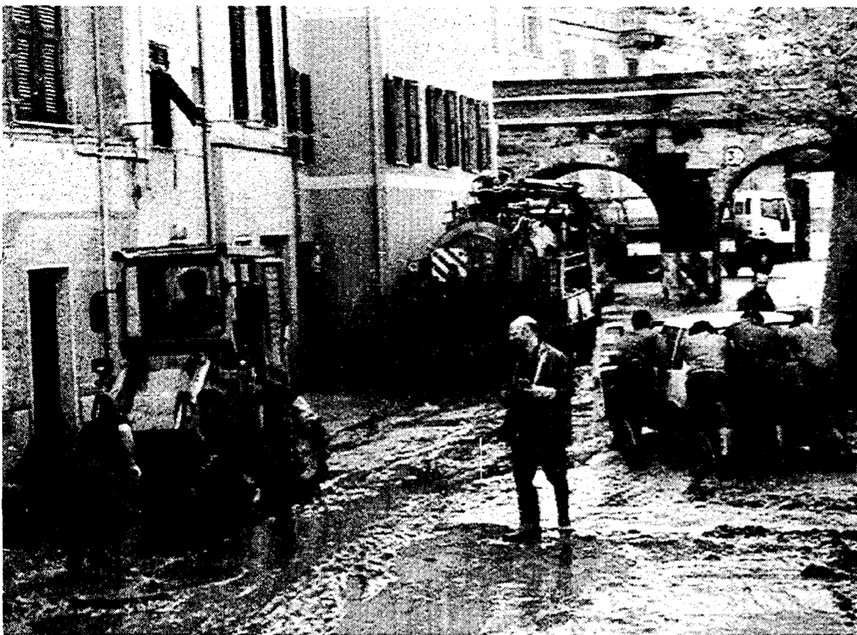
Vigili del fuoco rimuovono il fango in una strada di Genova dopo la piena del fiume Leira per il temporale abbattutosi sulla città
