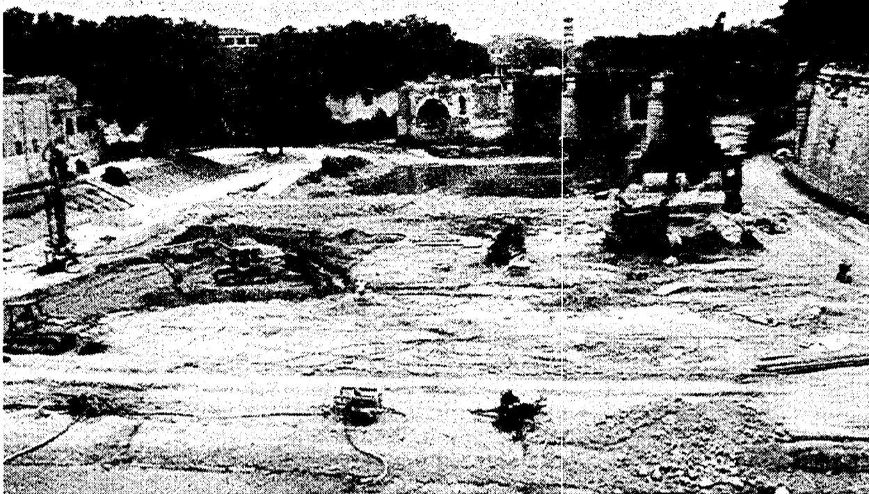
Lavori nell'alveo del fiume Tevere all'Isola Tiberina
