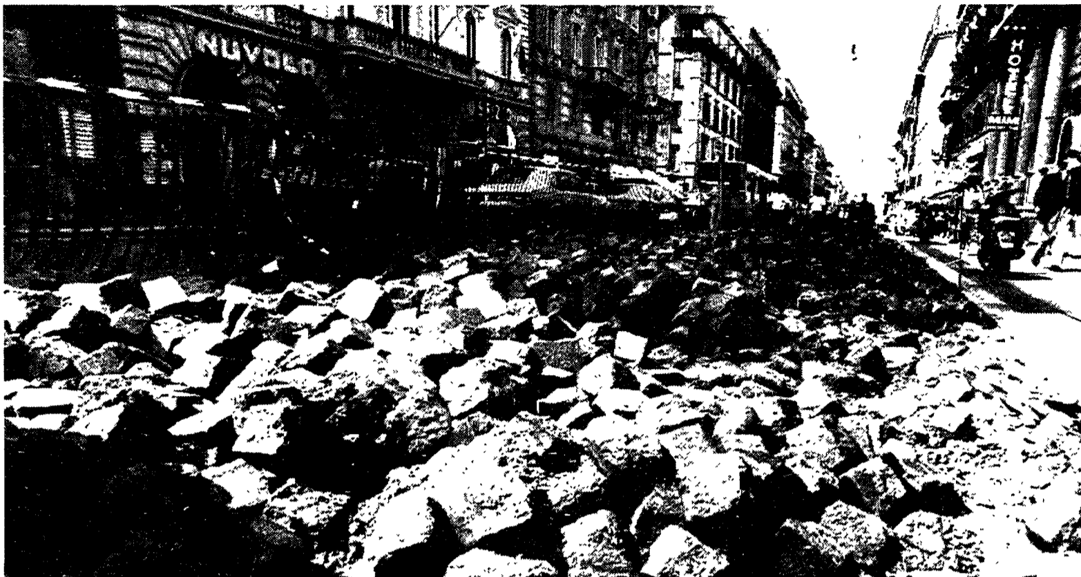
Lavori in corso a via Nazionale
