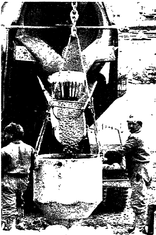
Operai di un cantiere edile
