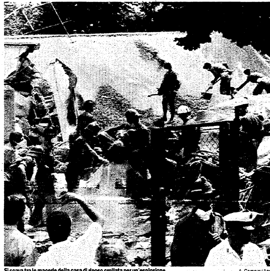
Si scava tra le macerie della casa di riposo crollata per un'esplosione
