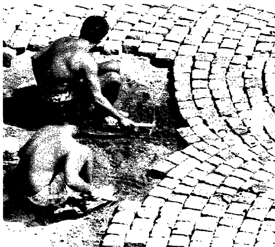
Lavori di pavimentazione di via Nazionale
