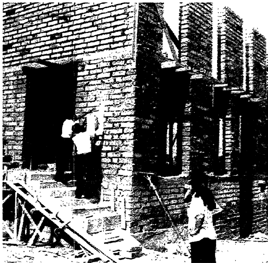
Vigili urbani pongono il foglio di sequestro su un manufatto alla Borghesiana
