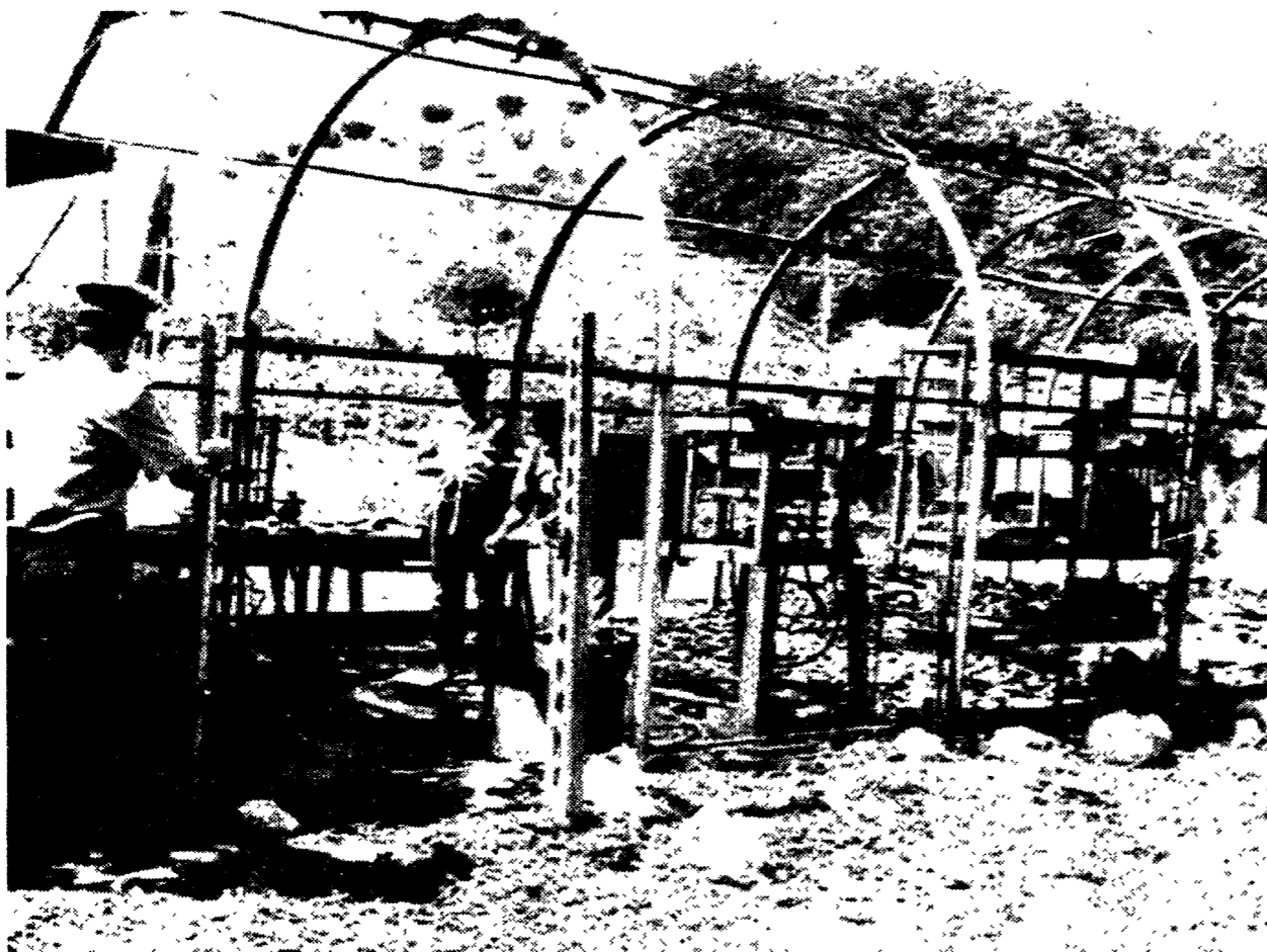
I carabinieri eseguono i primi rilievi nel capannone della «Protecnica Modema» di Corciano in provincia di Perugia
