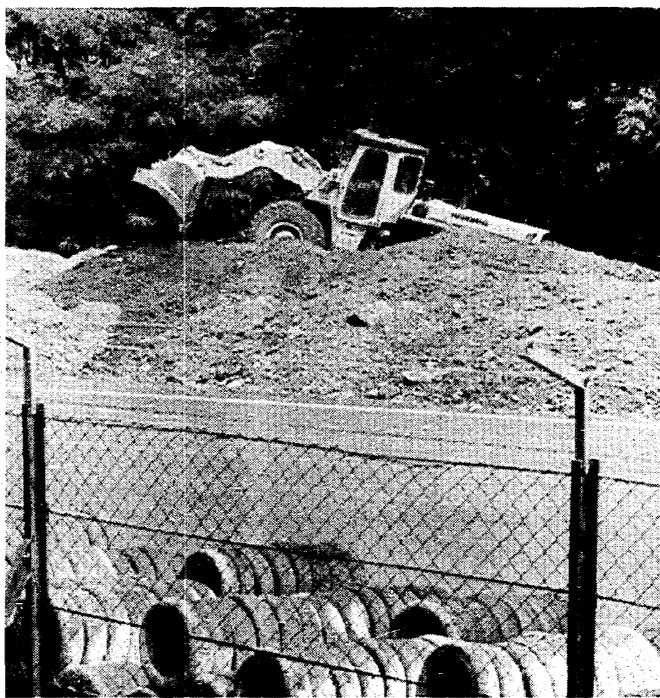
Lavori sulla pista di Monza
