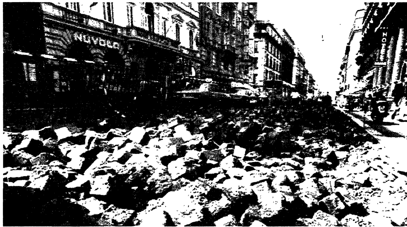
I lavori di risistemazione della pavimentazione di via Nazionale
