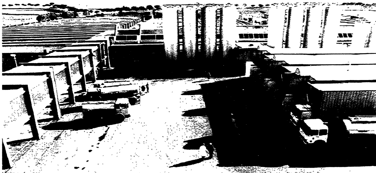
Piazzale di scarico della centrale del latte di Roma
