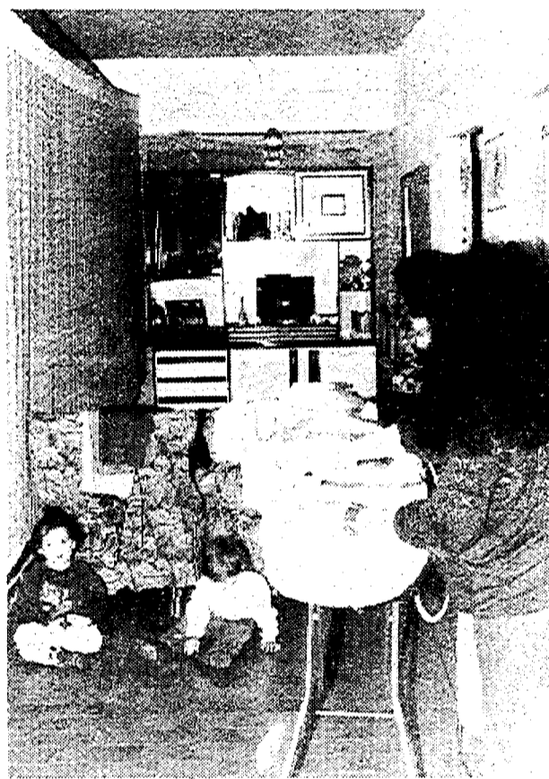
Uno dei locali a Laurentino 38, restaurato dagli occupanti, e in alto il forte degrado di un piano terra
