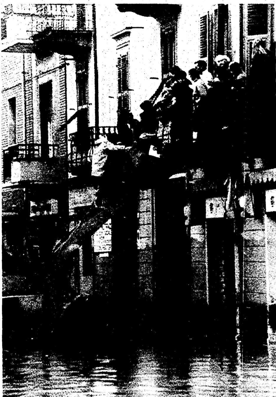
Alcuni abitanti di Alessandria, rimasti isolati dall'alluvione, vengono soccorsi con una ruspa
