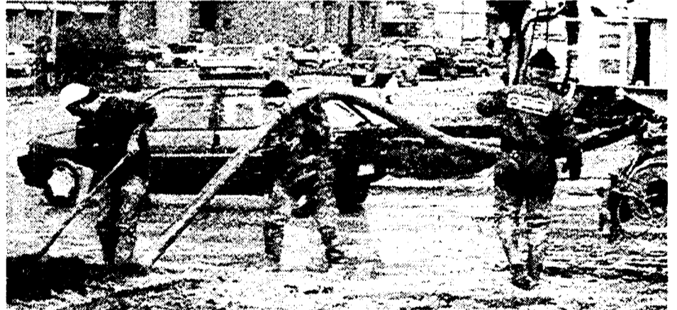
La rimozione del fango e di detriti al centro di Alessandria
