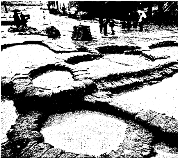
Fontanazzi: sotto controllo dopo il passaggio della piena
