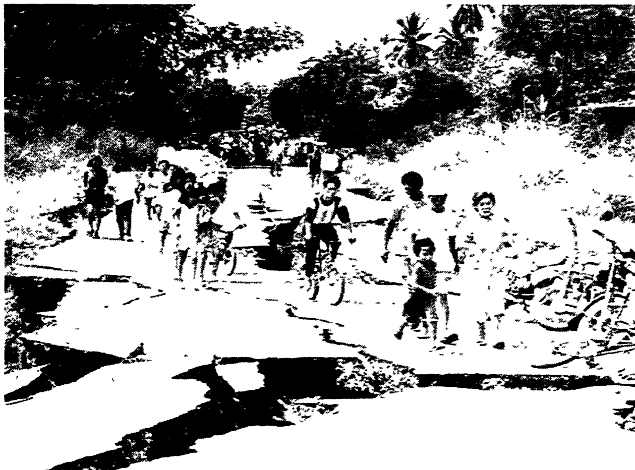
La strada di Bacolod, nelle Filippine; spaccata dal violento terremoto
