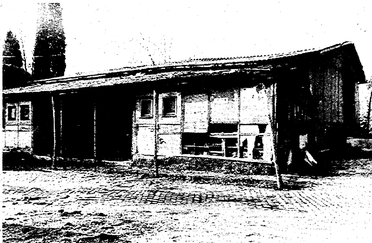
Il degrado del rimessaggio delle attrezzature nello stadio comunale dell'Acquacetosa. Sotto l'ingresso dell'impianto sportivo
