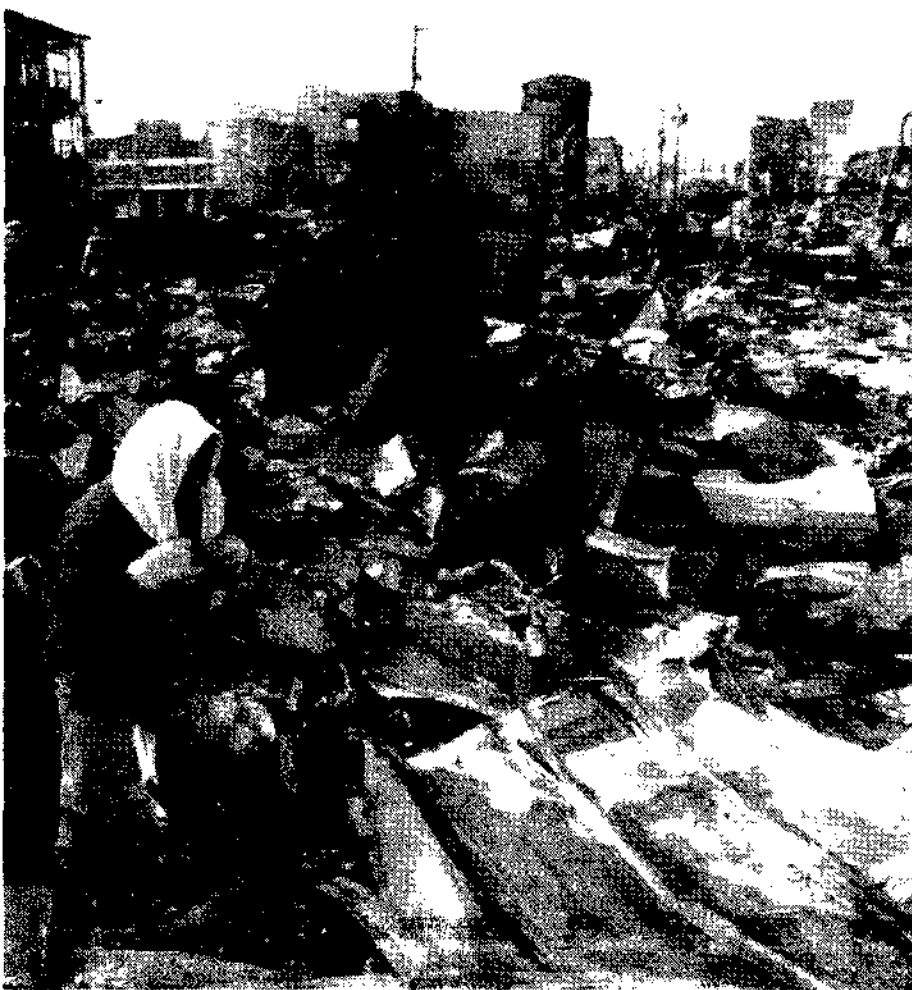
Una donna tra le macerie della sua casa distrutta dal terremoto
