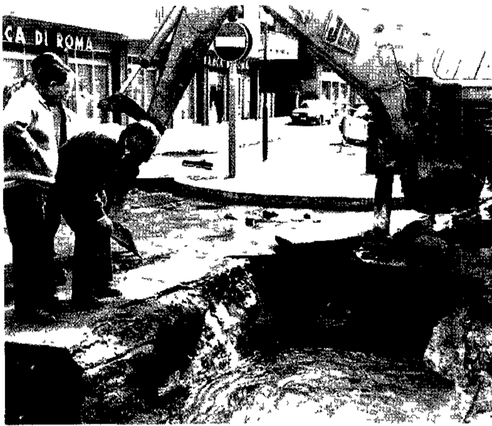
La buca che si è formata per la rottura di una condotta d'acqua in via Flaminia
