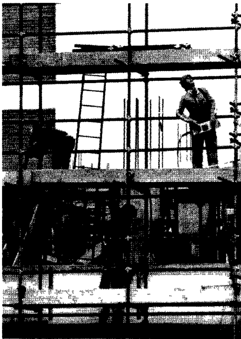
Operai a lavoro sul porteggio di un cantiere edile
