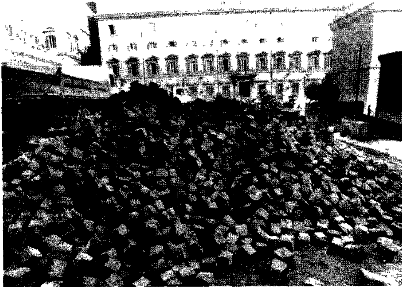
Lavori davanti Montecitorio
