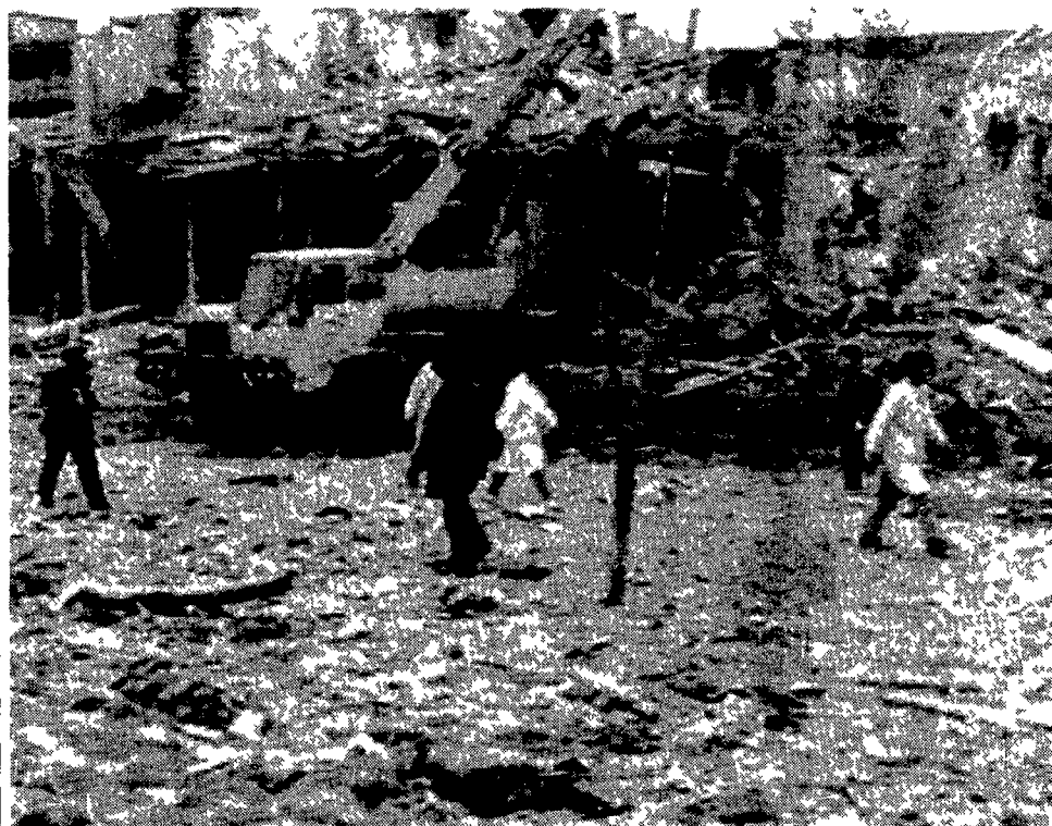
Soccorritori al lavoro dopo l'esplosione che ha distrutto il deposito di dinamite
