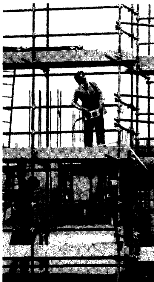
Un cantiere edile
