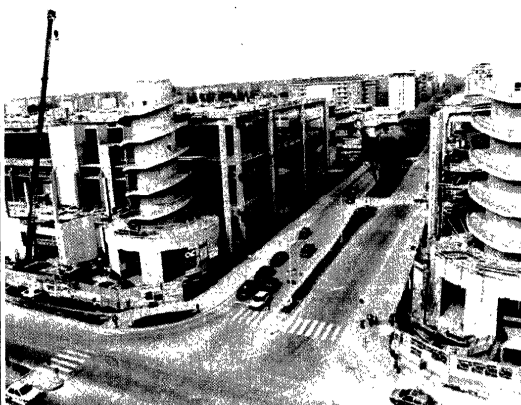
Il cantiere del Portello-Fiera in via Scarampo
