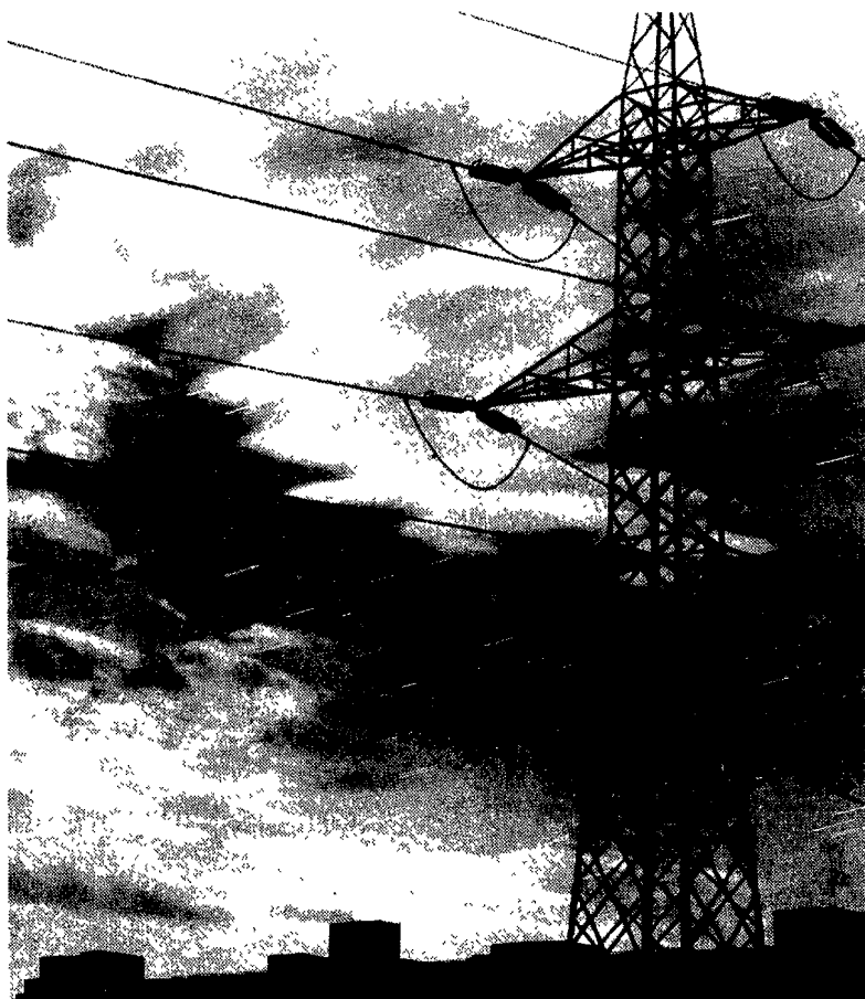
Un traliccio elettrico dell'Enel
