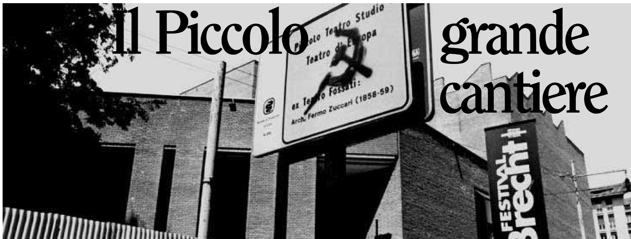
Il nuovo Piccolo Teatro di Milano è ancora in cantiere
