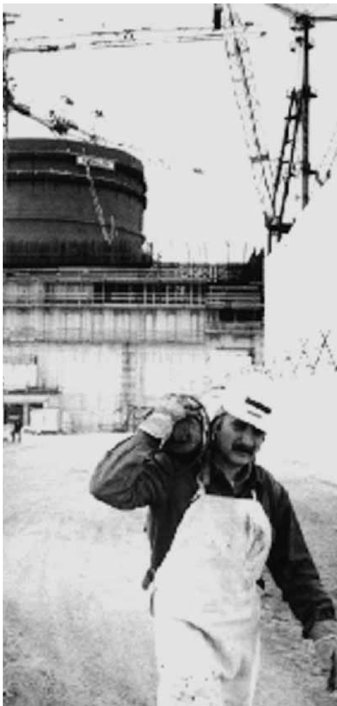
La centrale di Montalto di Castro
