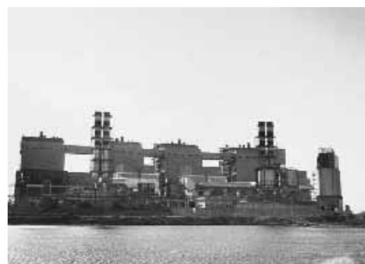
La centrale Enel di Brindisi
