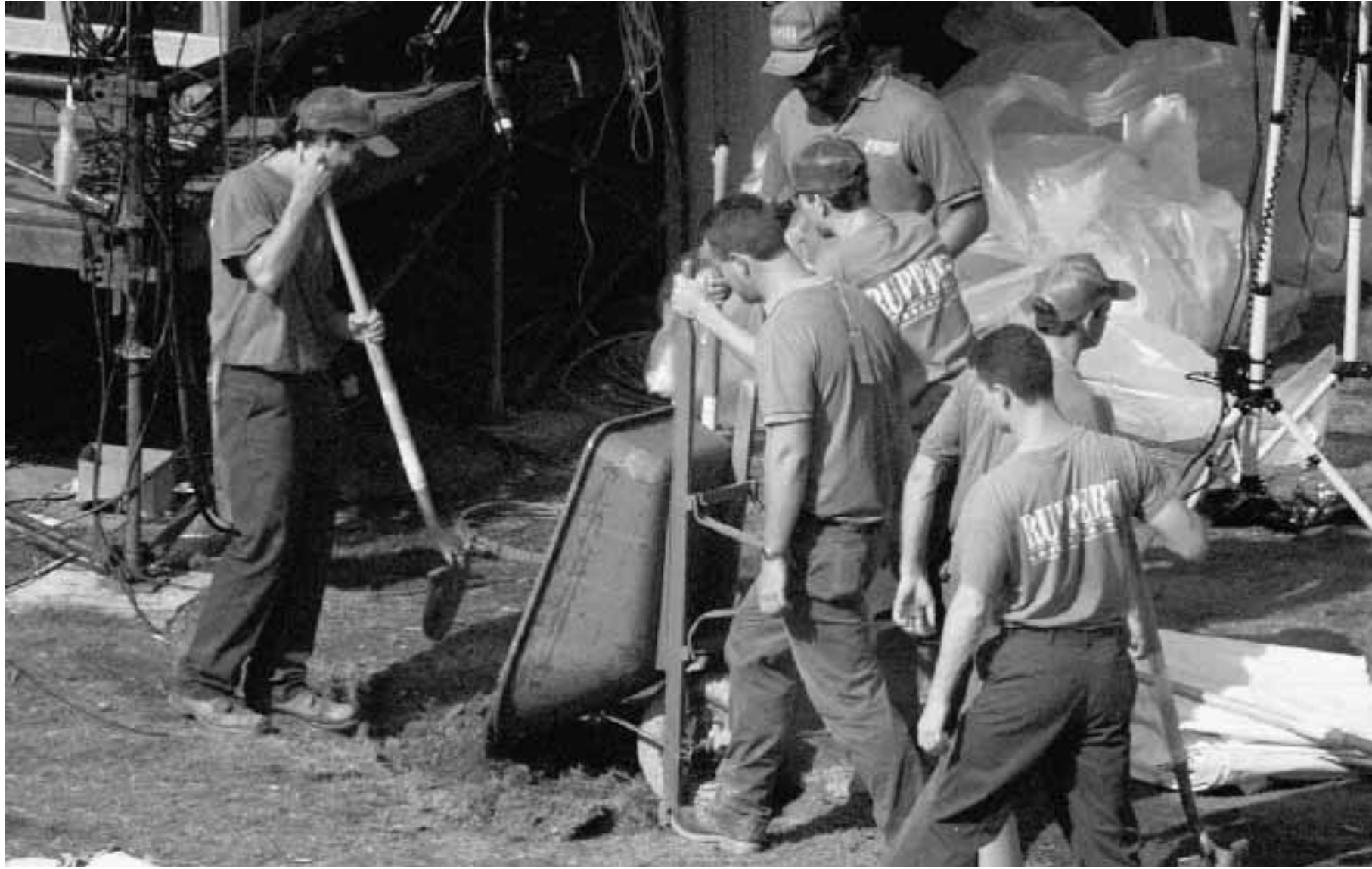
Operai al lavoro per riparare il cratere provocato dall'esplosione della bomba
