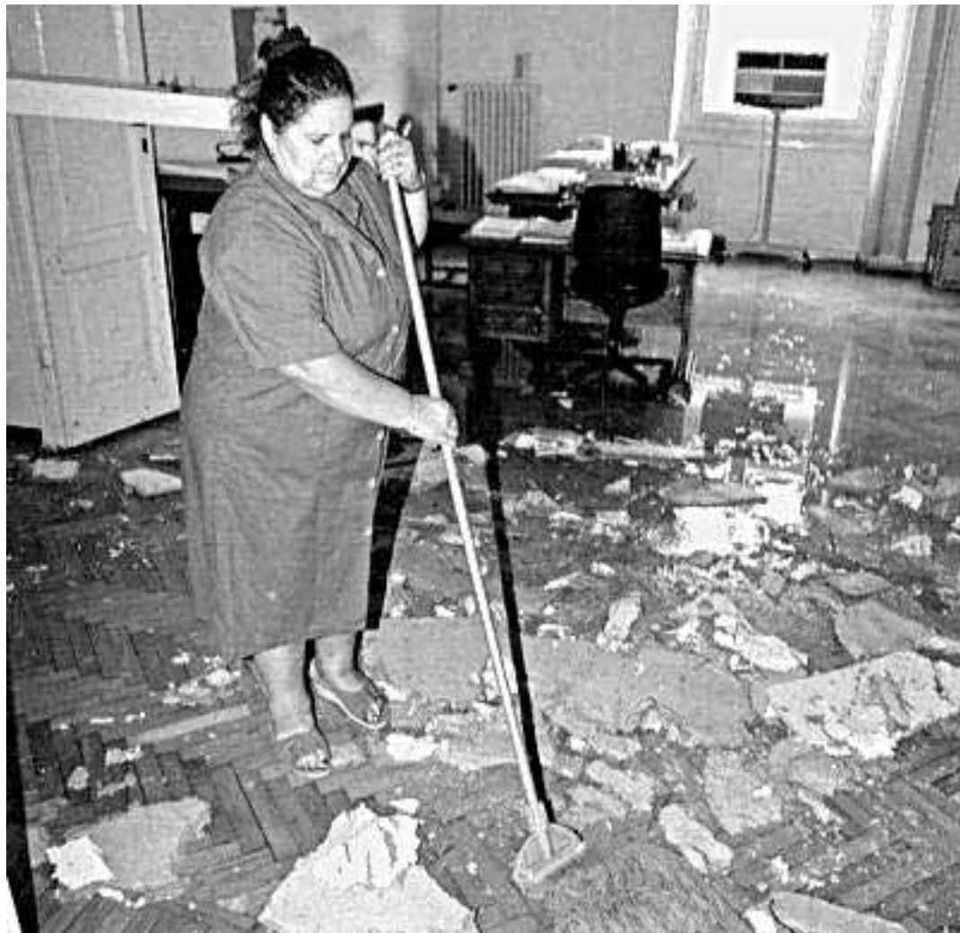
La rimozione dei frammenti del soffitto della Procura di Firenze crollato dopo il violento temporale
