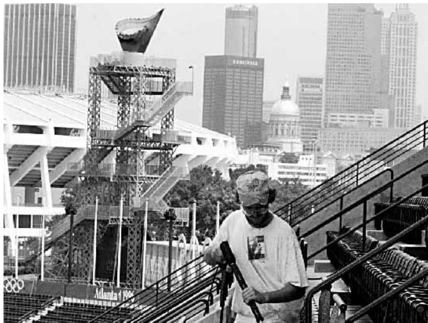
Si iniziano le operazioni di smontaggio dello stadio olimpico di Atlanta, mentre a Sydney, in basso, si lavora per il Duemila
