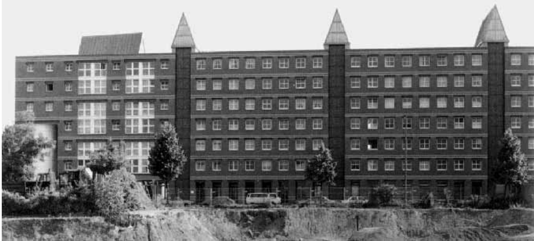
Friedrichstadt, edificio per abitazioni di Aldo Rossi
