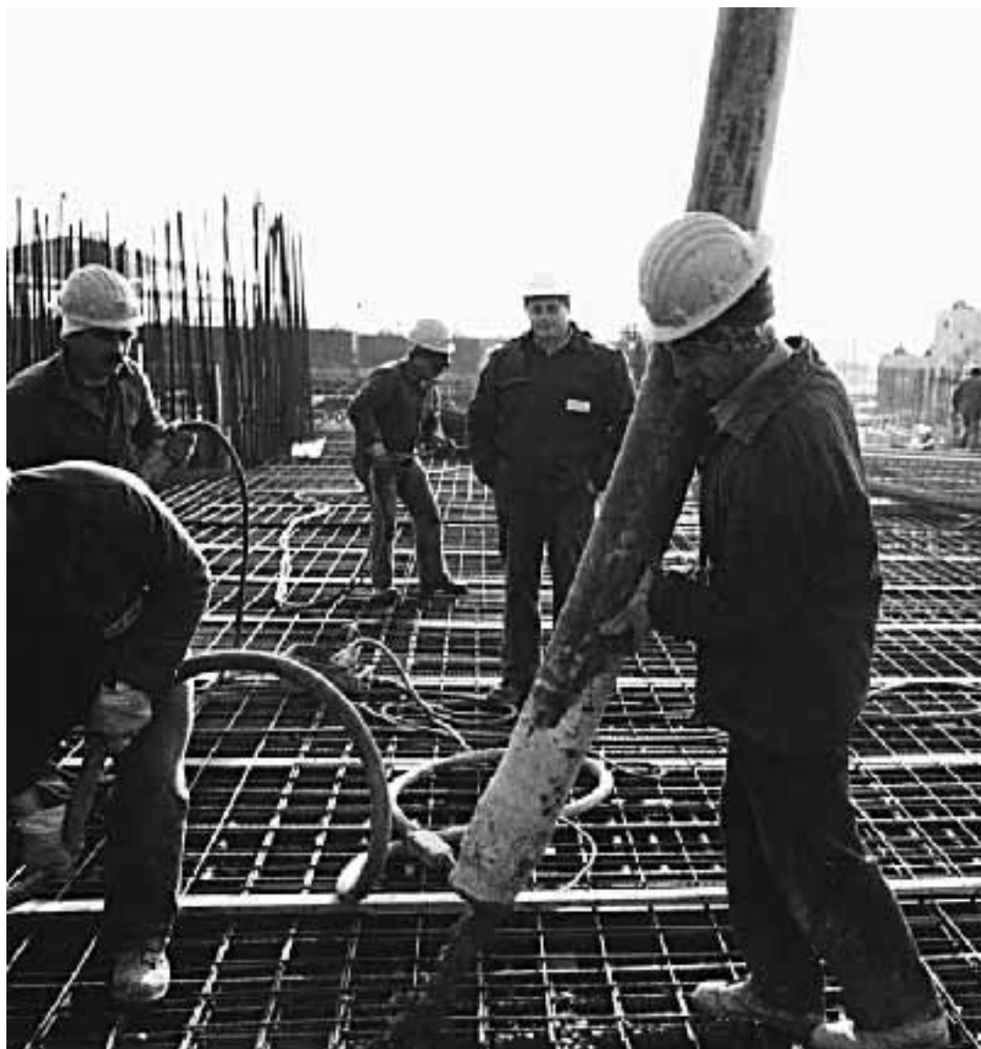
Operai edili durante la posa del cemento
