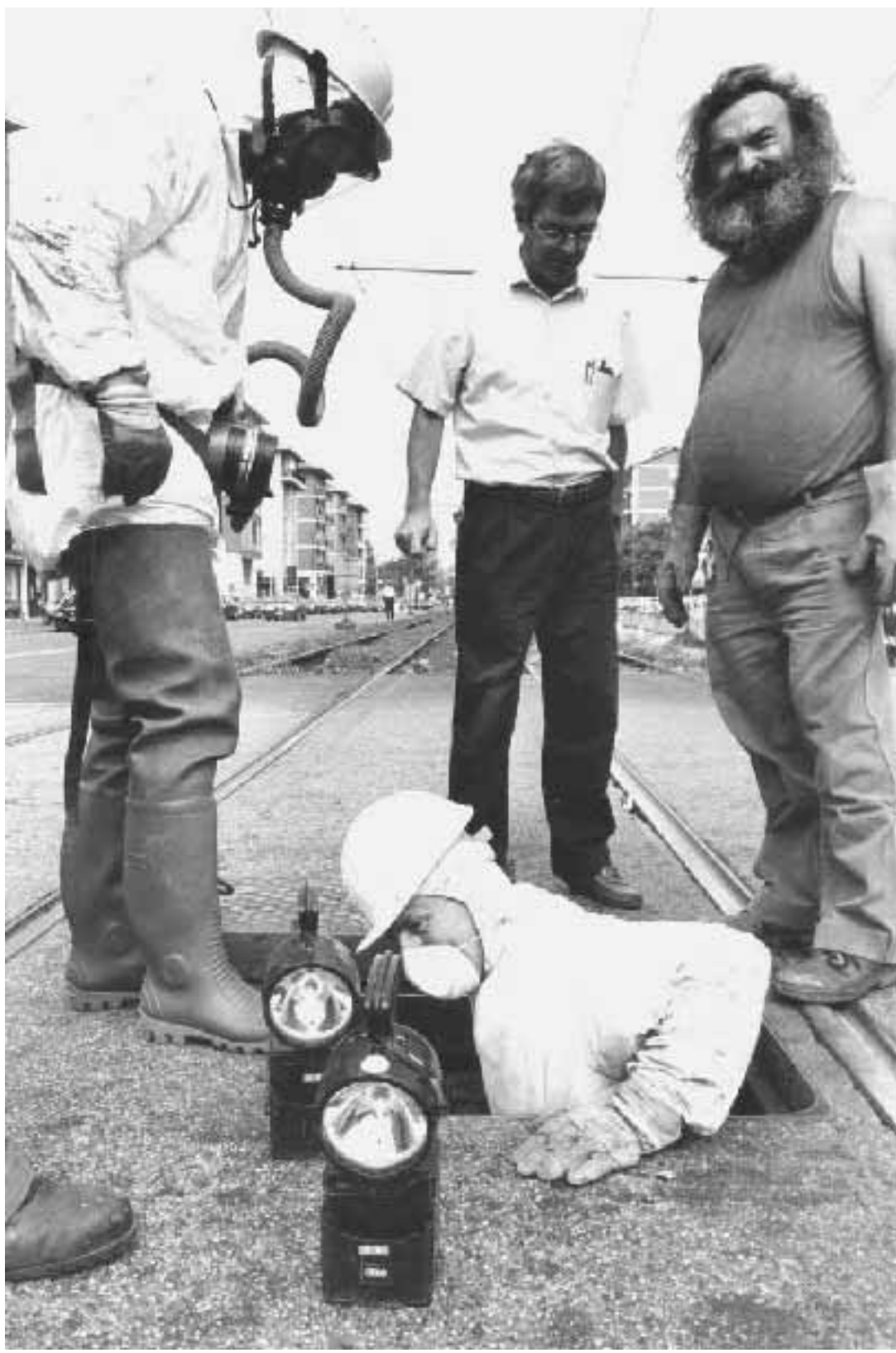
Controlli alla rete fognaria in via Mecenate
