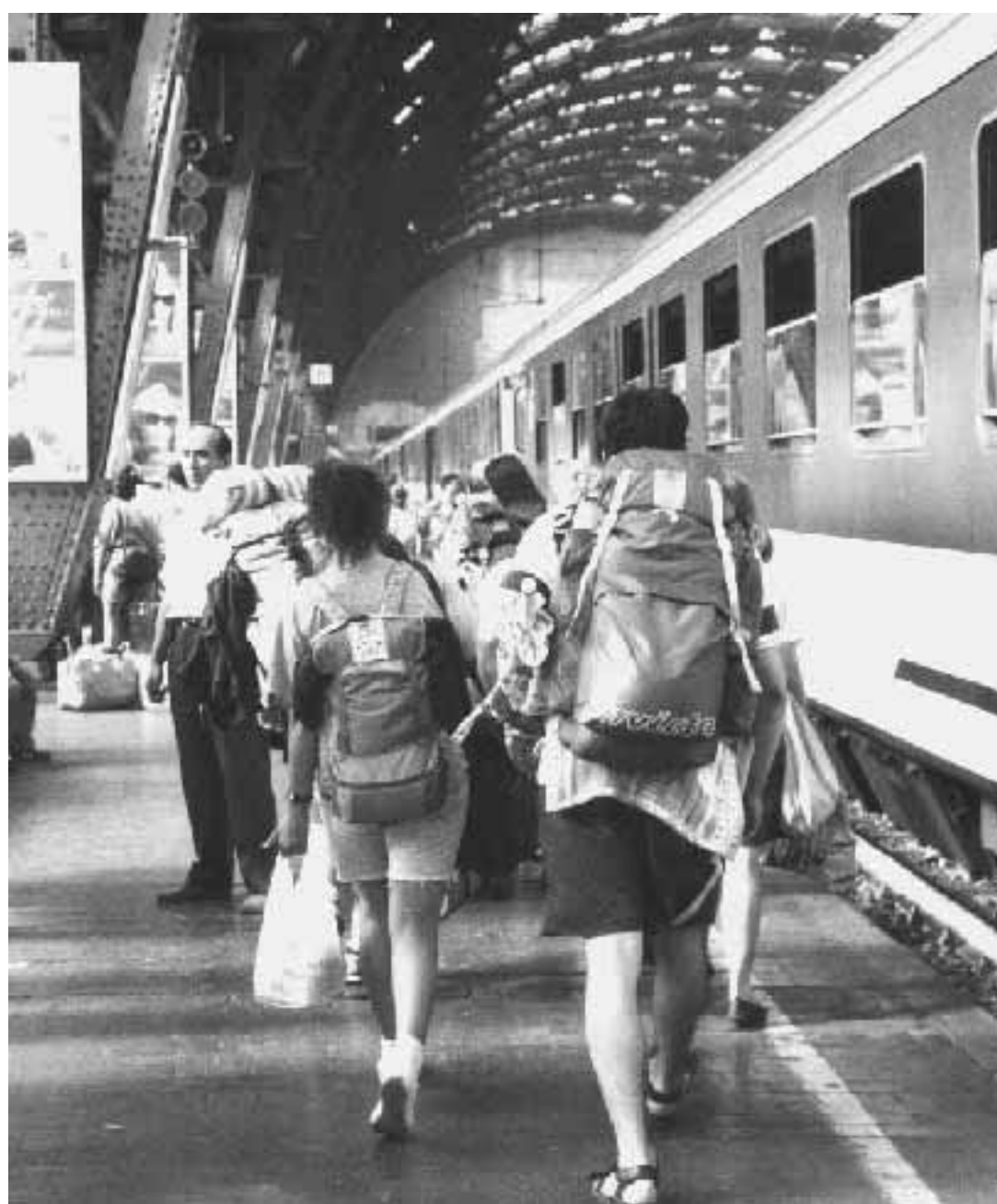
Giornate di grande rientro alla Centrale
