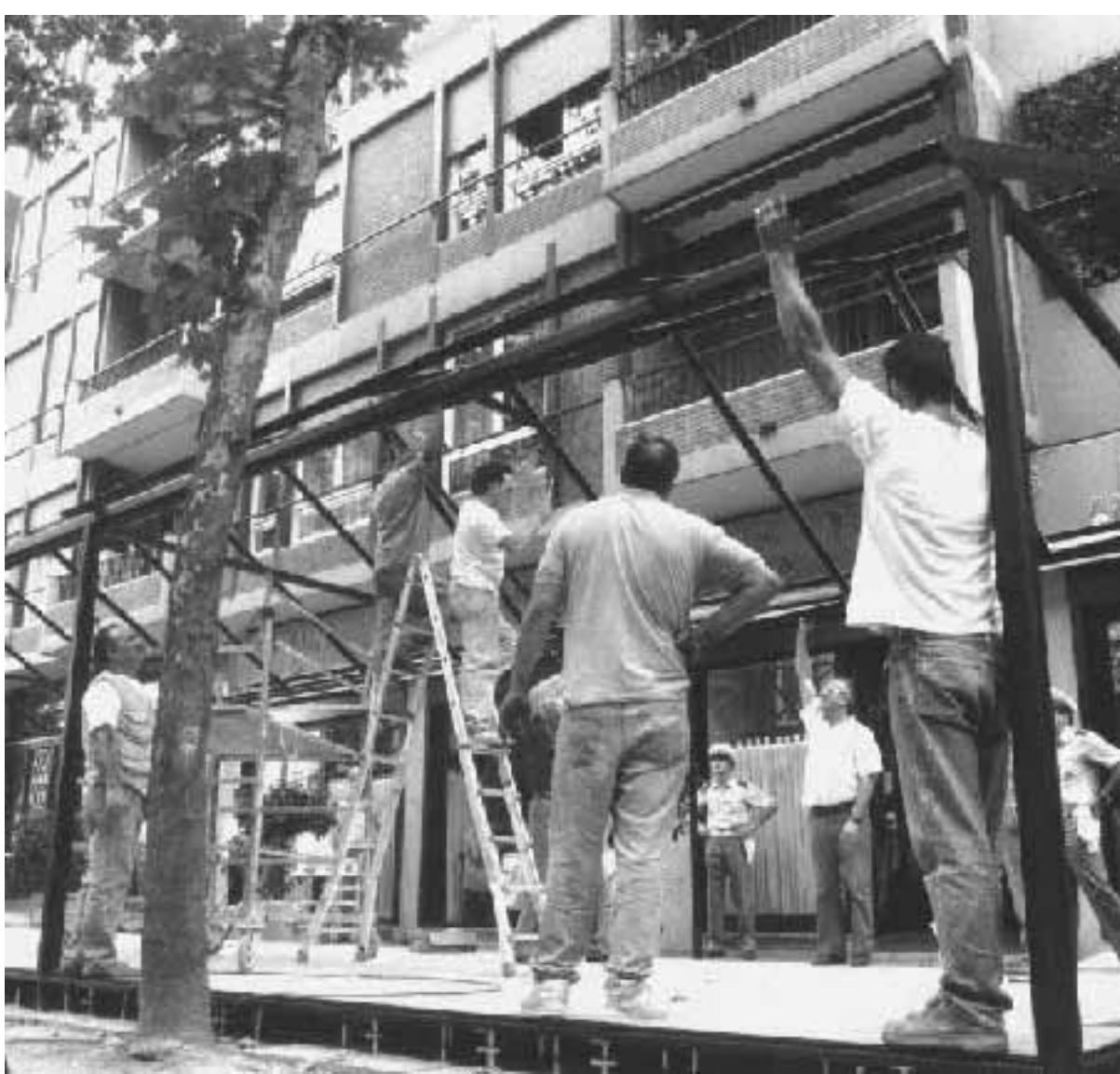
Lo smantellamento della veranda all'Original bar di via Sacco
