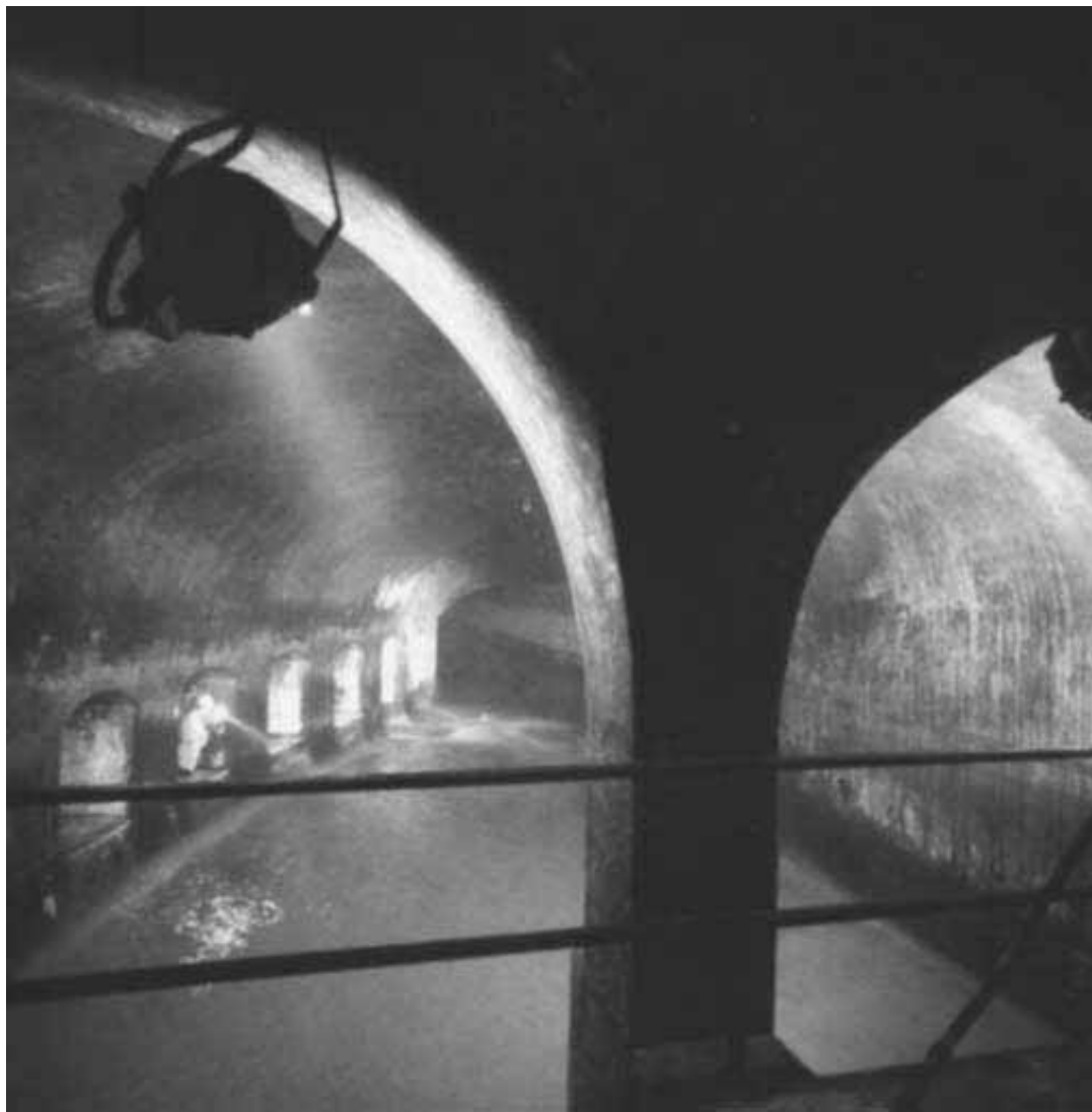
Il manufatto della rete fognaria sotto piazza Bonomelli uno dei più importanti nodi idraulici della città Cesare Colombo
