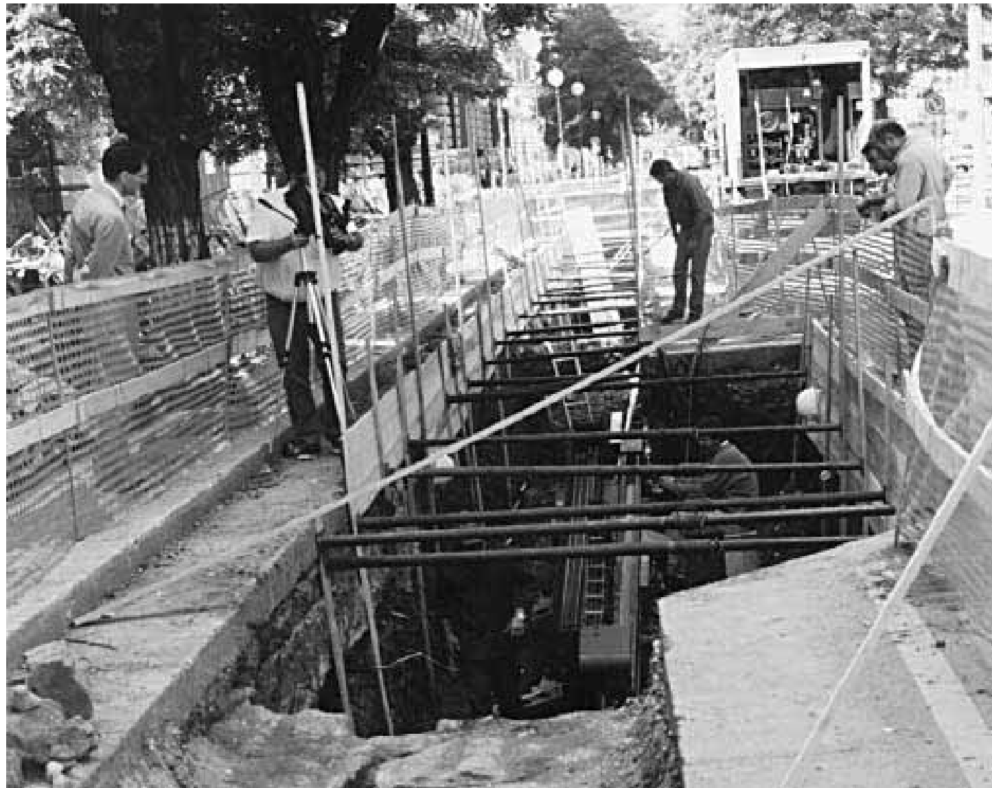
Uno scavo per la posa della rete elettrica dell'Enel, in basso il mosaico rinvenuto durante i lavori
