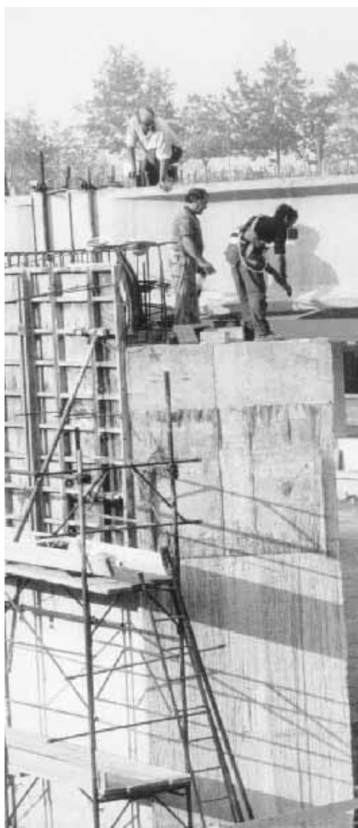
Operai di un cantiere edile
