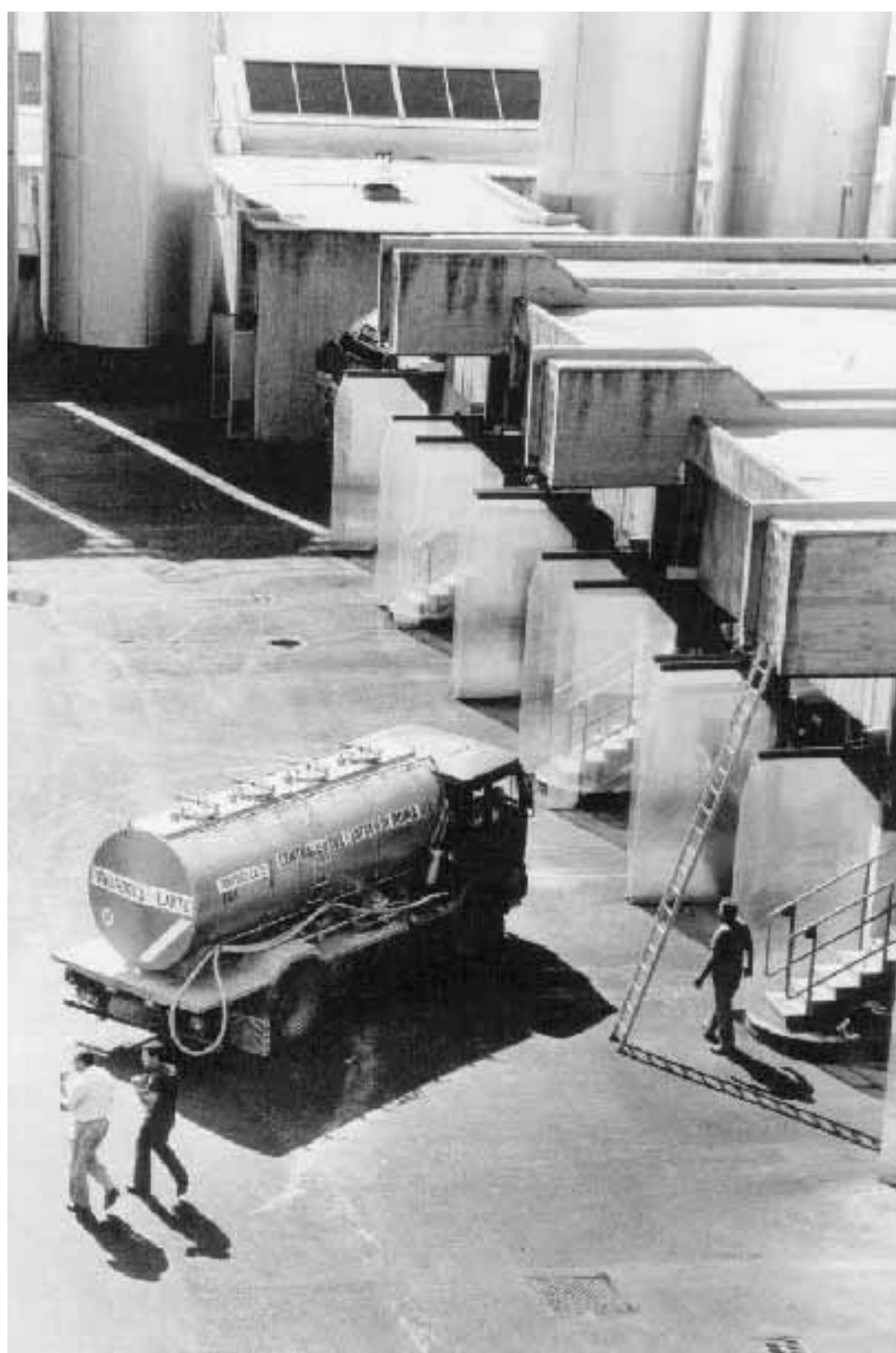
Una veduta della Centrale del Latte
